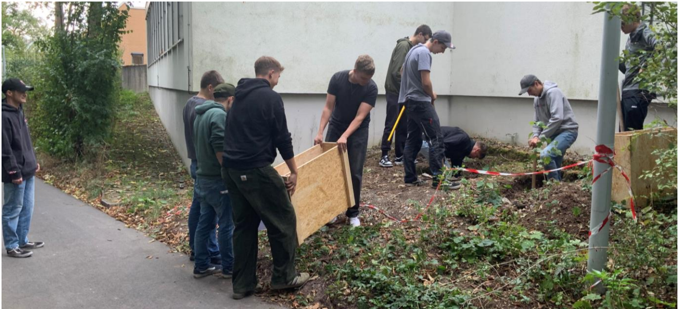
Vorbereitungsarbeiten für die Installation der Wärmepumpe
